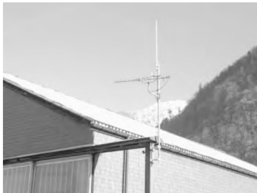
Die Antennen am neuen Standort des Digipeaters HB9GL auf dem Flugplatz Mollis. Oben die Rundstrahlantenne für den User-Zugang auf 2 m, darunter die 70 cm- und 23 cm-Yagis, die Richtung Atzmännig strahlen. Von hier aus haben wir Sichtverbindung zum Digipeater Atzmännig
