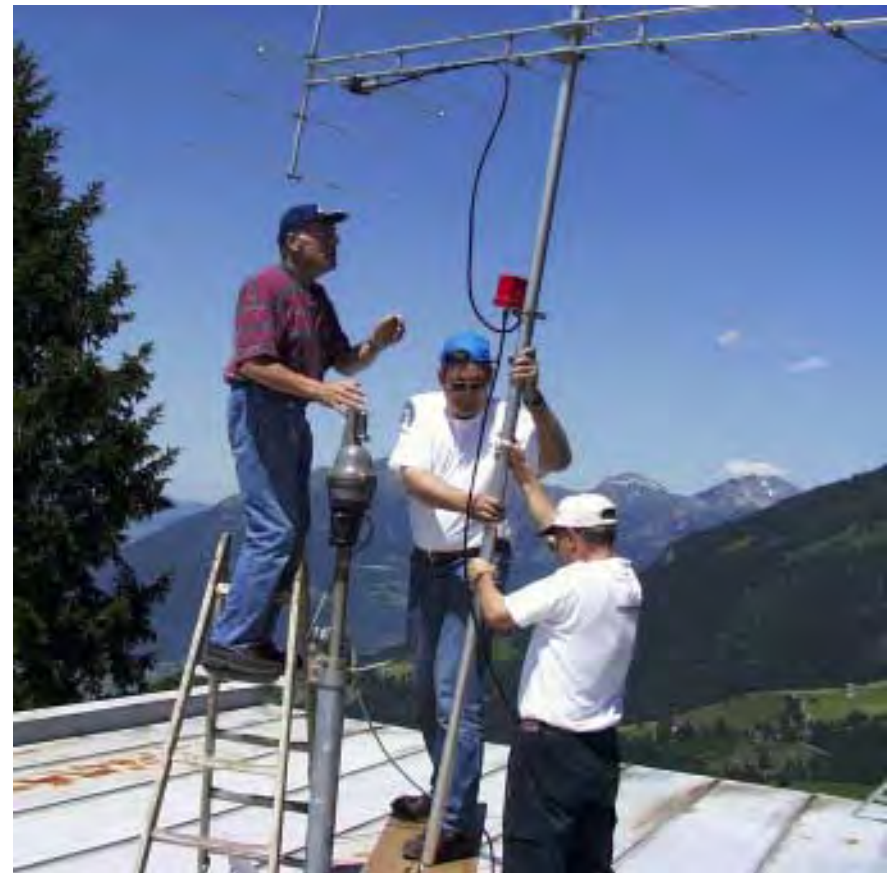
Antennenbau mit Tücken
